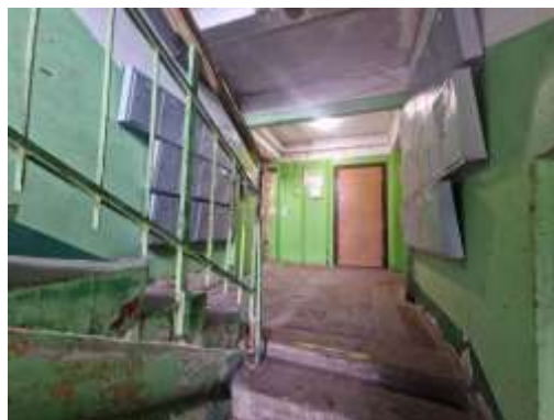
1.stāva kāpņu telpa
